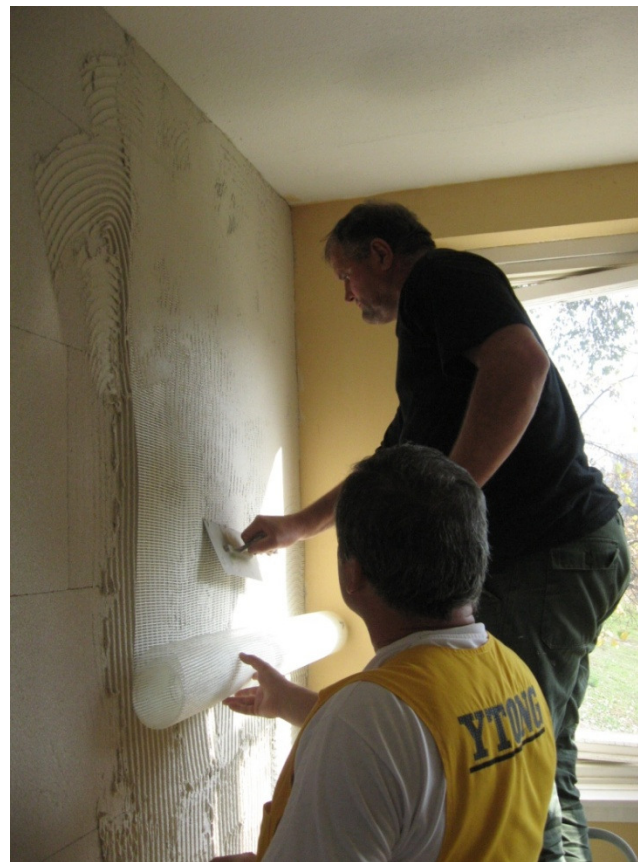
Ágyazó réteg (Multipor habarcs) és üvegszövet erősítő háló elhelyezés
