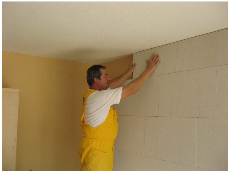
Záró sor elhelyezése
