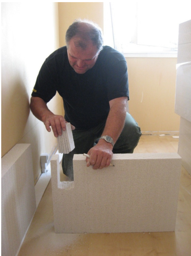
Szerelvények helyének kialakítása
