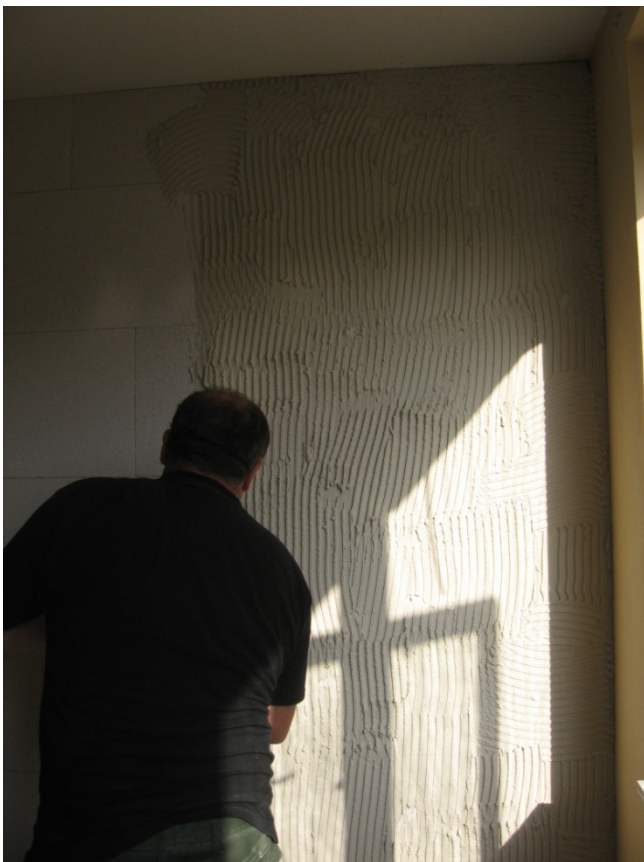
Ágyazó réteg (Multipor habarcs) és üvegszövet erősítő háló elhelyezés
